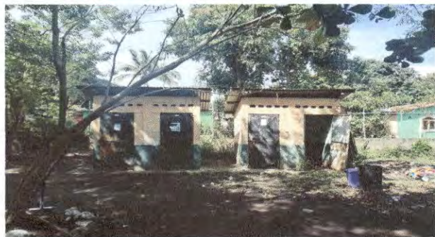
Foto 7: MODULO A Vista de modulo de servicio sanitario. Se hara un levanado de 0.90mts x 2.20 mts para conforma otro modulo para sanitario ,
