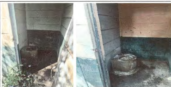
Foto 11: Se deben de sustituir letrinas por sanitarios lavables, se debe de prolongar red de agua potable con tubería pvc
