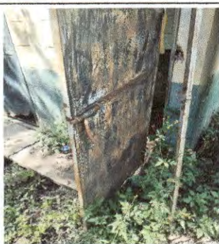
Foto 3: MODULO A SERVICIO SANITARIO vista de puerta de metal es servicio sanitario a ser reemplazada.
