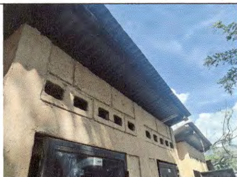
Foto 5: MODULO A SERVICIO SANITARIO Vista frontal de cubierta de zinc a ser reemplazada
