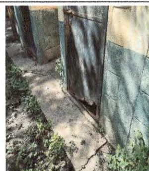
Foto 4: MODULO A SERVICIO SANITARIO Vista de puertas en mal estado a ser reemplazadas
